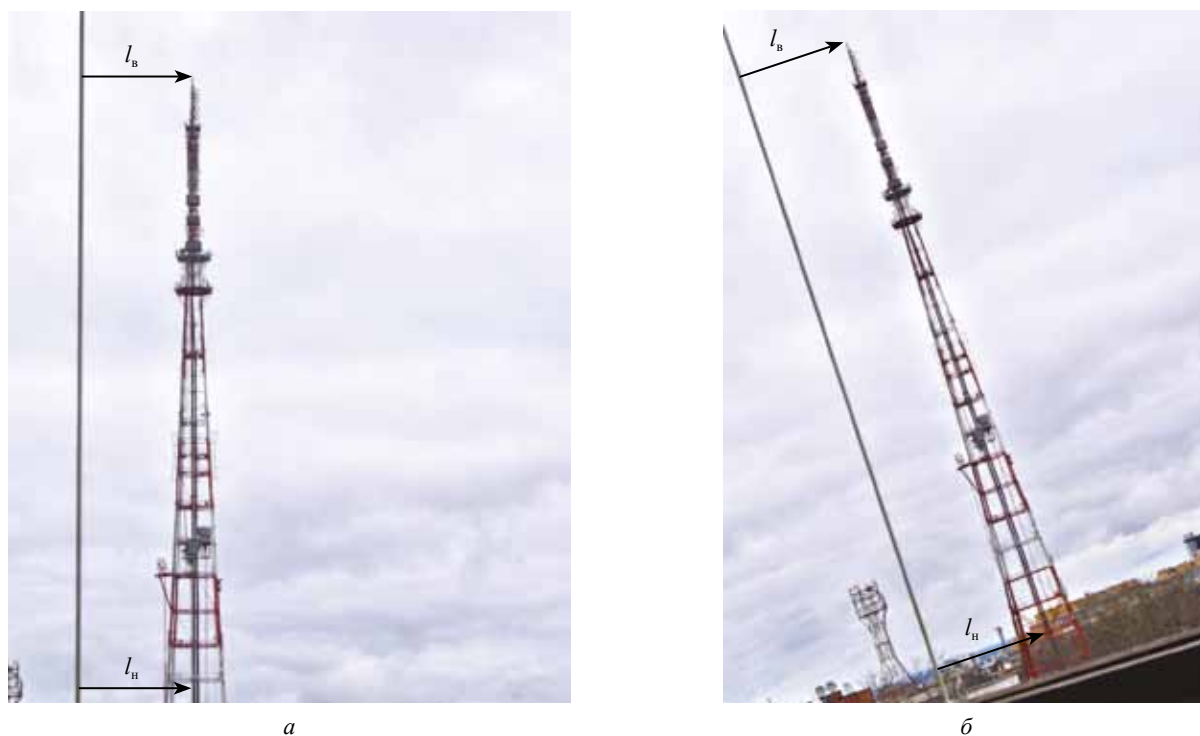
Рис. 5. Фотографии телебашни и шнурового отвеса
