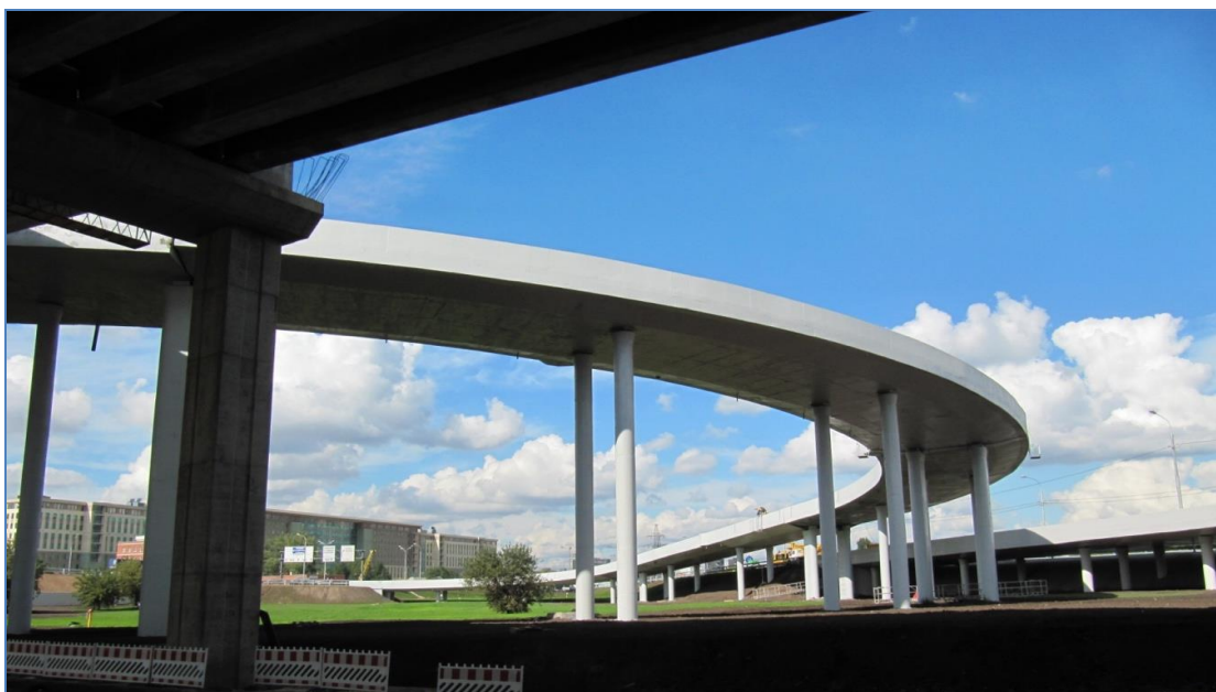
Рисунок 5. Съемка низа бетона ПСС электронным тахеометром SET 350 RX (Sokkia). Авторазвязка МКАД – г. Люберцы
