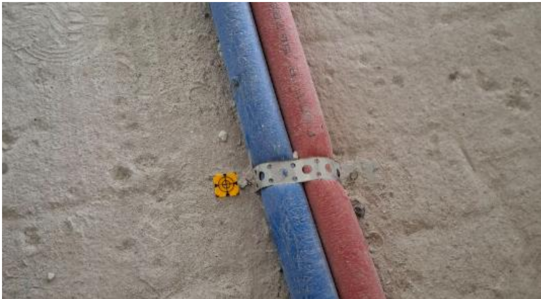
Рисунок 31 – Закрепление опорных и контрольных точек
