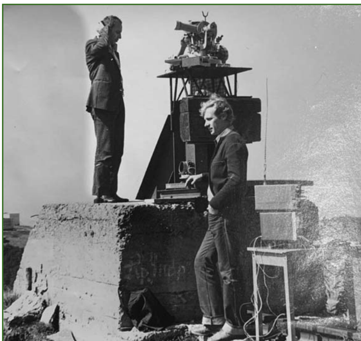
Определение астрономических координат, 1980-е гг.
