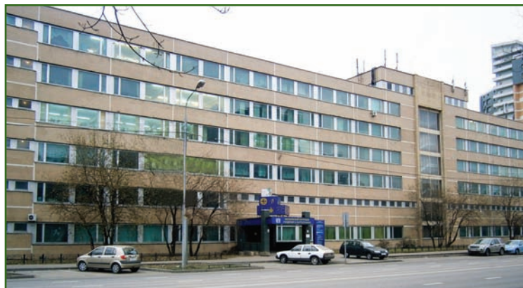
Здание МКГиК на ул. Молодогвардейская, дом 13
